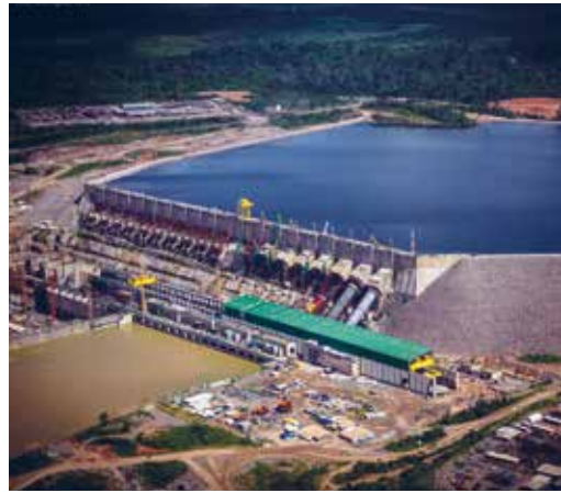
Usina Hidrelétrica de Belo Monte construída sem consulta aos povos afetados, 2016
