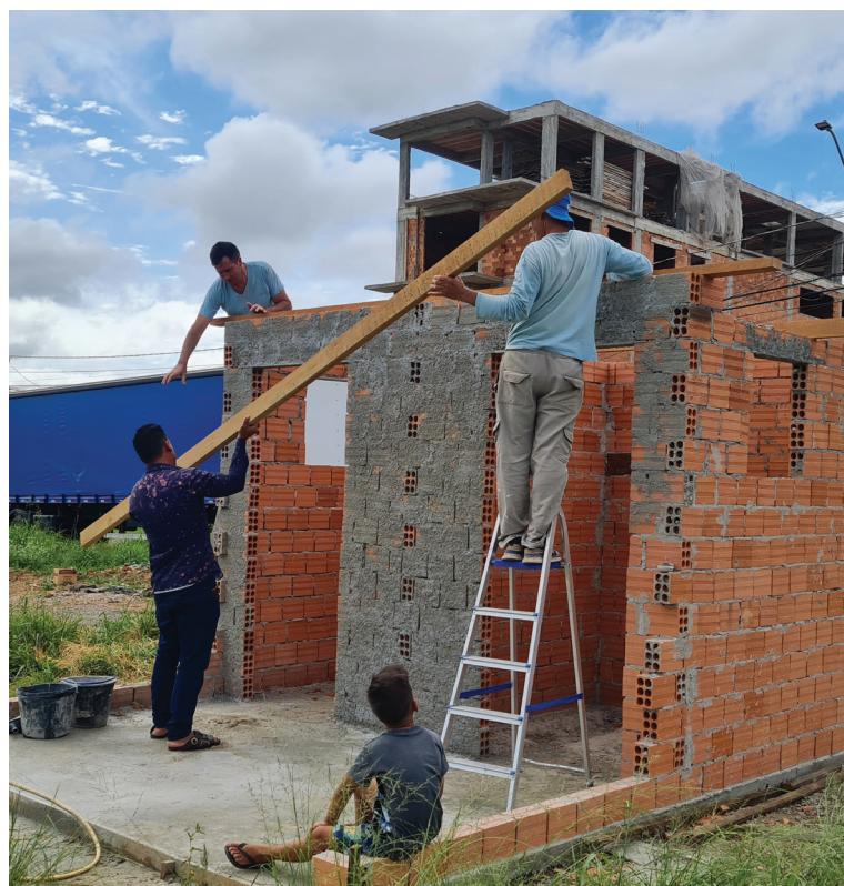
CONSTRUÇÃO DO BANHEIRO NA COMUNIDADE
