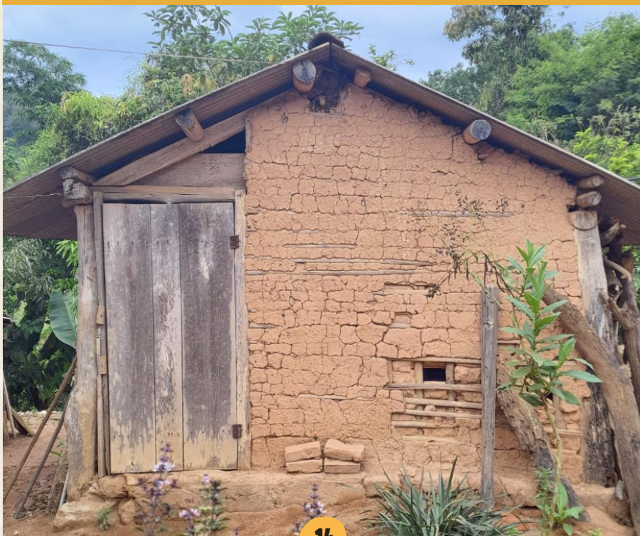
Figura 7 - Casa construída em tecnologia de Pau a Pique
