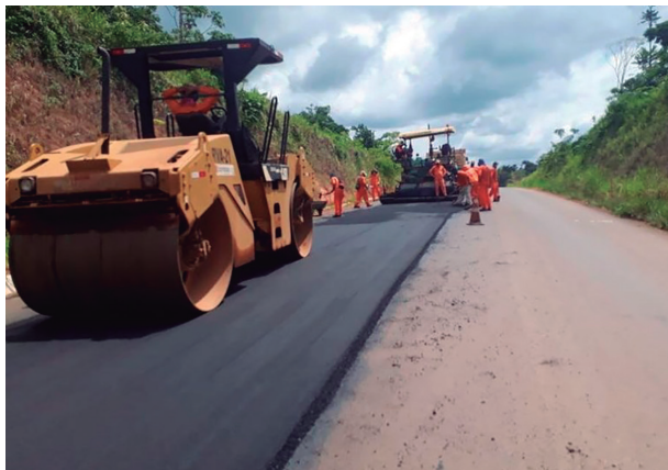
Obras de asfaltamento da Rodovia BR 230.
